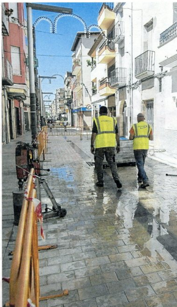
Operaris amb els últims detalls de l'obra. FOTO: JOAN REVILLAS
