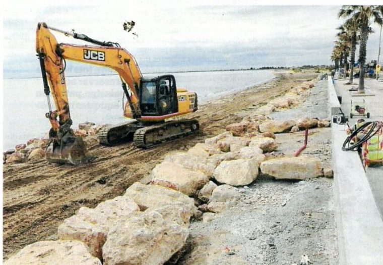
Pla de les obres a l'Ampolla, on s'està enllestint una escullera. FOTO: ACN
