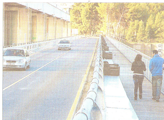
Imatge de la nova passarel·la de vianants sobre el pont de la presa de l'embassament de Flix, ahir a la tarda. FOTO: ANDREU CARALT
