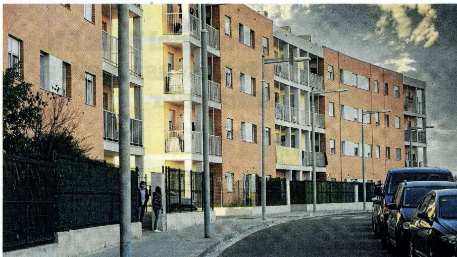
Alguns dels pisos del parc d'habitatge públic d'Amposta. FOTO: JOAN REVILLAS
