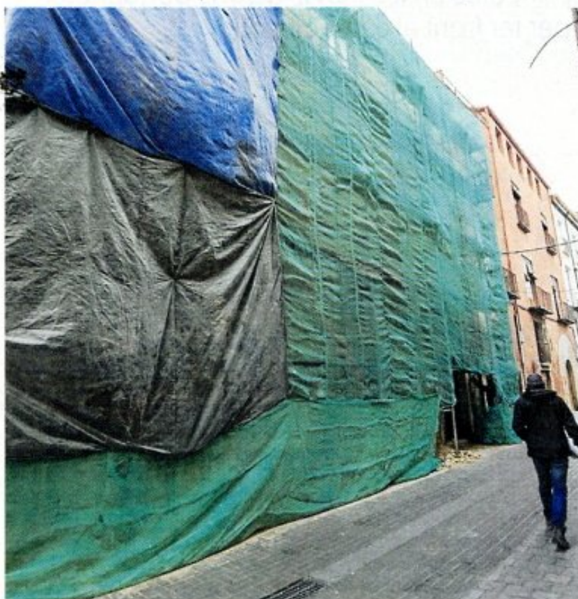
Imatge d'arxiu d'un edifici en rehabilitació al nucli antic. FOTO: J. REVILLAS
