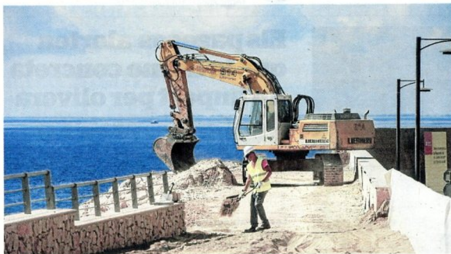
Operaris als treballs de Ports de la Generalitat al port de l'Ametlla, ahir al matí. FOTO: JOAN REVILLAS
