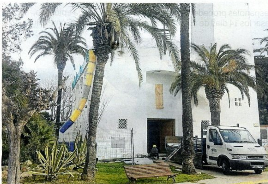
L'església de Poble Nou del Delta en obres. FOTO: AJUNTAMENT D'AMPOSTA
