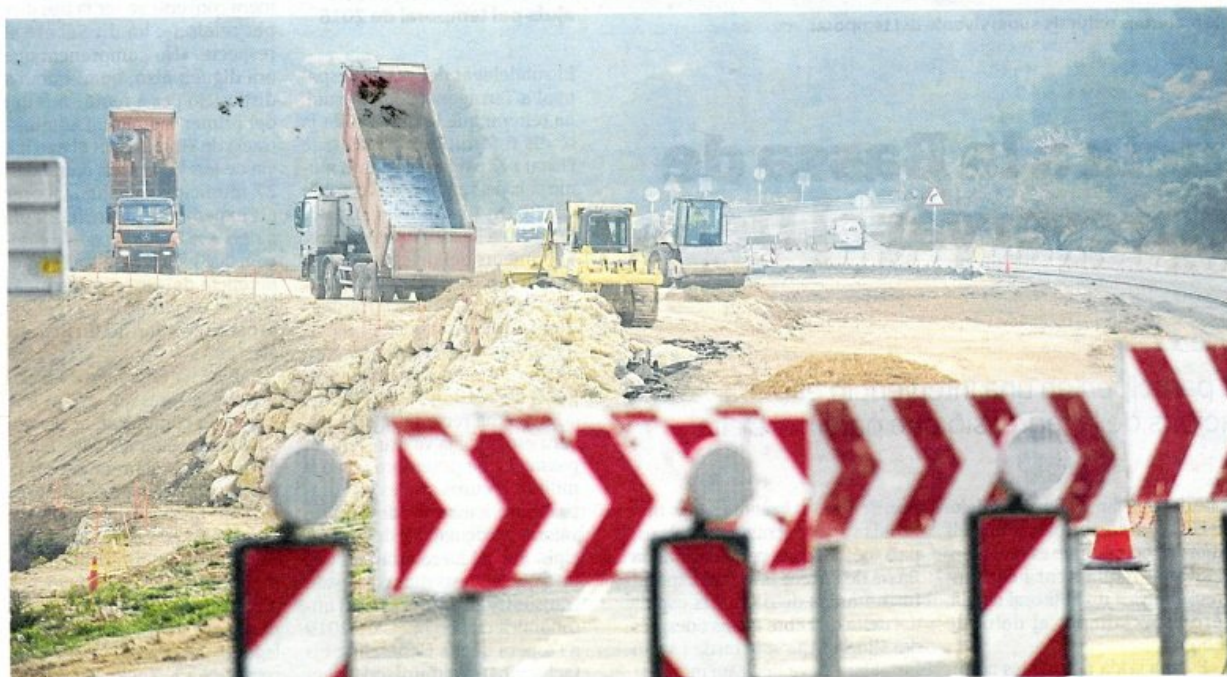
Estat de les obres a la carretera C-43, a l'accés a Gandesa. FOTO: JOAN REVILLAS
