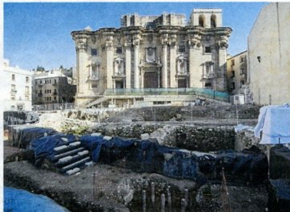
Estat actual de la plaça davant la catedral, amb les obres aturades. FOTO: JOAN REVILLAS
