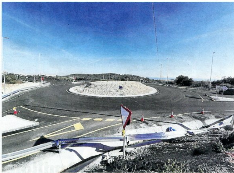
Estat actual de la nova rotonda de la carretera N-340 a Sant Carles de la Ràpita, construïda pel Ministeri de Foment.
