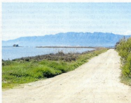
Imatge del petit tros de camí de guarda construït. FOTO: JOAN REVILLAS
