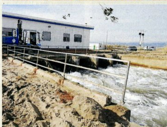
El abans i el després de les feines per retirar l'arena que obstruïa l'estació de bombeig de Pal. FOTOS: JOAN REVILLAS
