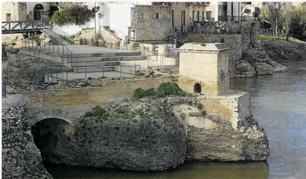
Àrea del castell d'Amposta on s'han de fer les obres. FOTO: JOAN REVILLAS
