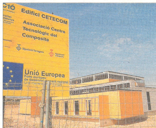
Estat de les obres del nou centre tecnològic al polígon d'Oriola de la capital del Montsià la setmana passada. FOTO: A. GARALT
