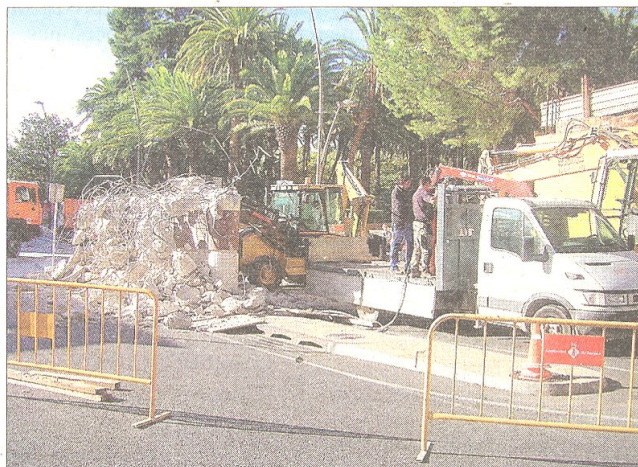
Treballs per enderrocar la pilastra de l'antic pont del tren sobre l'avinguda Generalitat. FOTO: M. MILLAN
