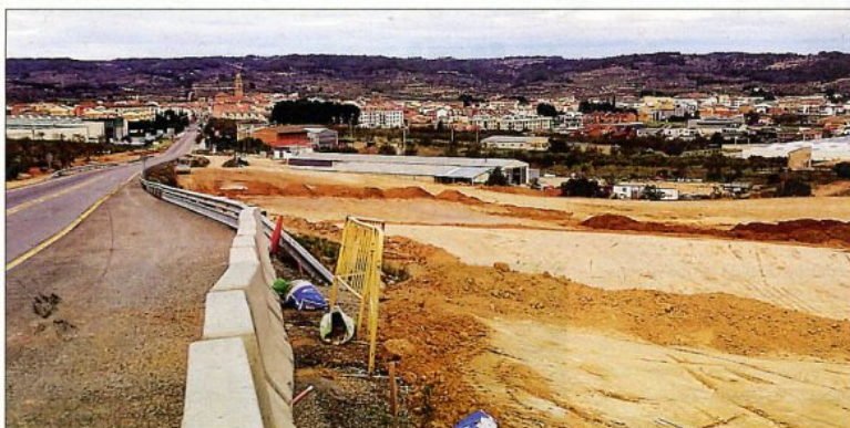
Imatge de les obres actuals a la C-43 abans d'arribar a Gandesa, en el punt on començarà la futura variant. / G.B.
