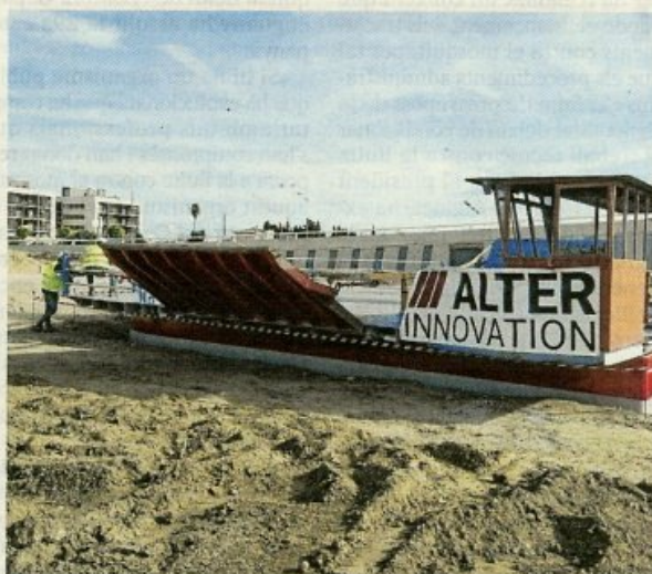
Obres de fixació al sòl de l'antiga barcaassa 'La Cava', ahir.
