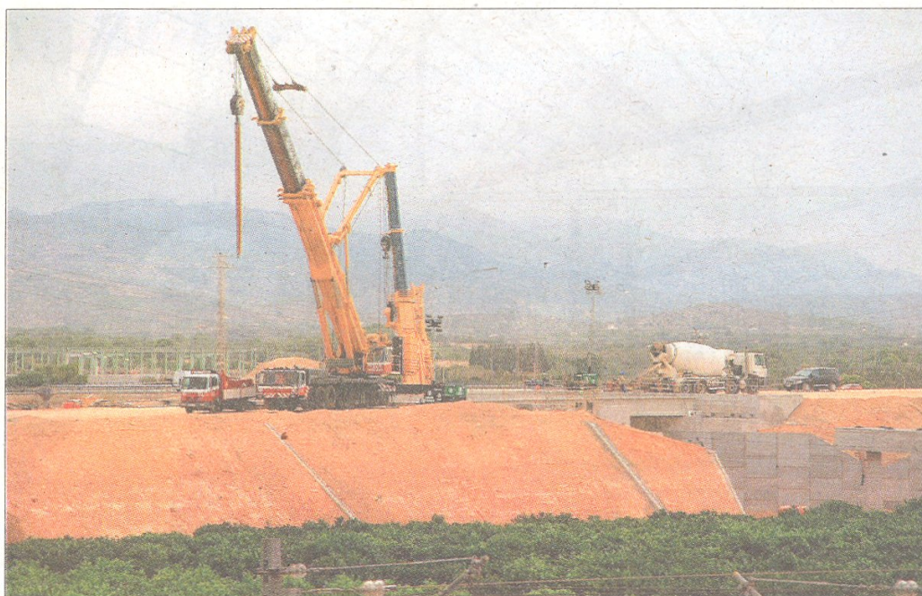
La variante de la carretera N-340 en L'Aldea, actualmente en construcción. FOTO: A. CARALT
