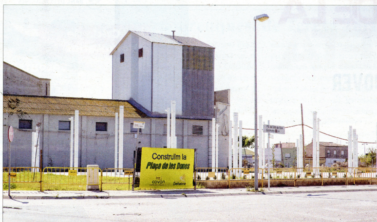
Imatge d'esta setmana de la plaça de les Dones, a la meitat de l'execució. / CEDIDA
