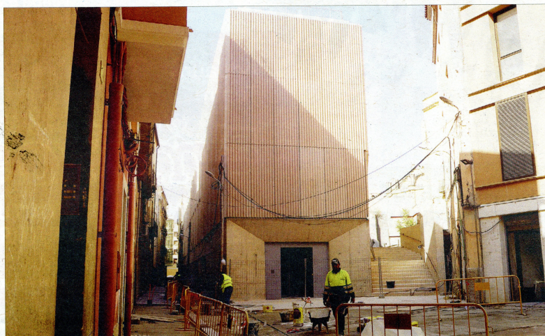
Imatge recent de l'edifici, a la plaça dels Estudis de Tortosa. / NÚRIA CARO
