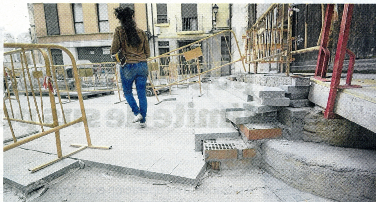
Les escales originals amb les noves de formigó a sobre. FOTO: JOAN REVILLAS
