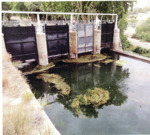
Imatge del punt de captació del canal de l'esquerra, a l'alçada de l'Assut al terme municipal de Tivenys.
