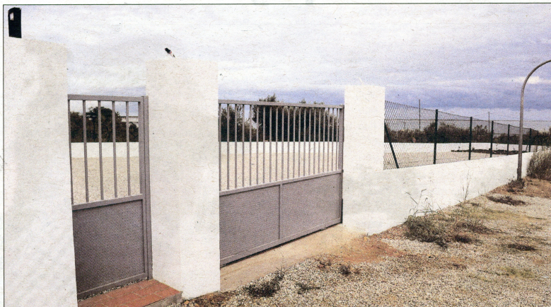
Imatge actual del solar urbanitzat on hi havia la casa on es va produir l'explosió. / N. CARO
