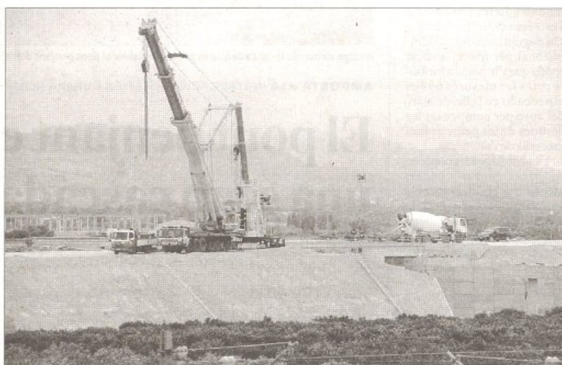
Maquinària pesada ahir al migdia en un dels talussos de la variant de la N-340 a l'Aldea. FOTO: A. CARALT
