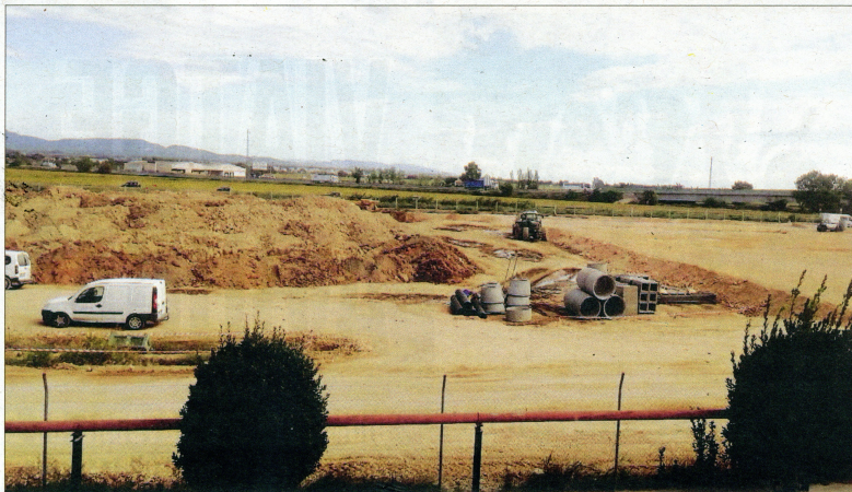
Imatge dels treballs d'ampliació de la planta de DAPSA de l'Aldea. / CEDIDA
