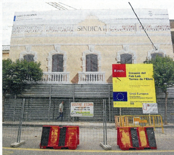
Imatge de l'edifici en obres de l'antic Sindicat, a Amposta, ahir a la tarda. FOTO: JOAN REVILLAS
