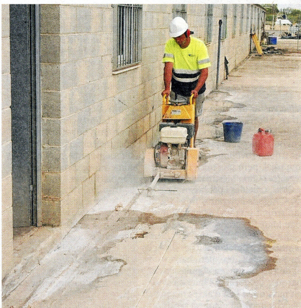
Les obres s'han iniciat pel enderroc dels paviments. FOTO: J. REVILLAS
