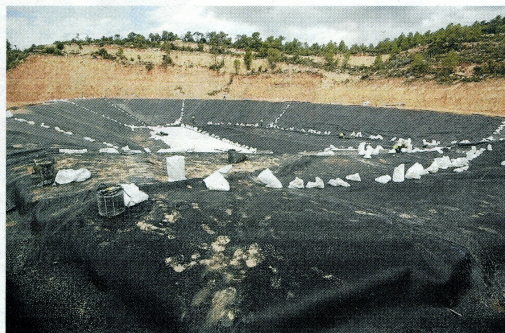
Imatges en exclusiva dels espais on s'ubicarà el dipòsit i el centre de valorització de residus. FOTO: JOAN REVILLAS
