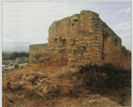
La Torre de Soldevila de Tortosa, d'estil gòtic, es troba avui pràcticament derruïda. FOTO: JOAN REVILLAS
