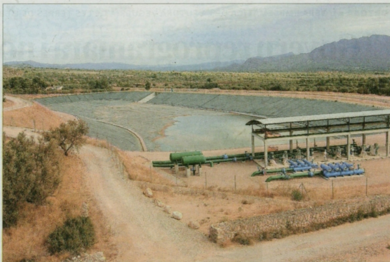
Una de les basses de regulació construïdes al primer tram de la infraestructura. FOTO: JOAN REVILLAS
