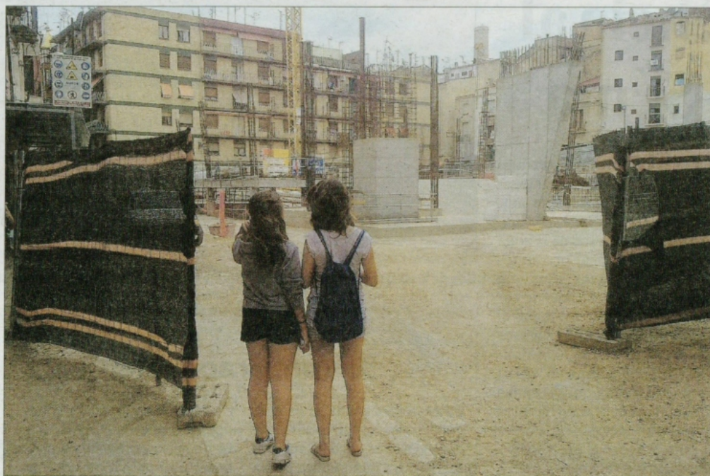
Estat de les obres del nou edifici de les delegacions territorials de la Generalitat a Tortosa, ahir. FOTO: J. REVILLAS
