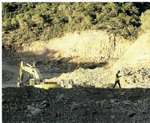
Imatge de les obres del dipòsit de residus, ahir a la tarda.
