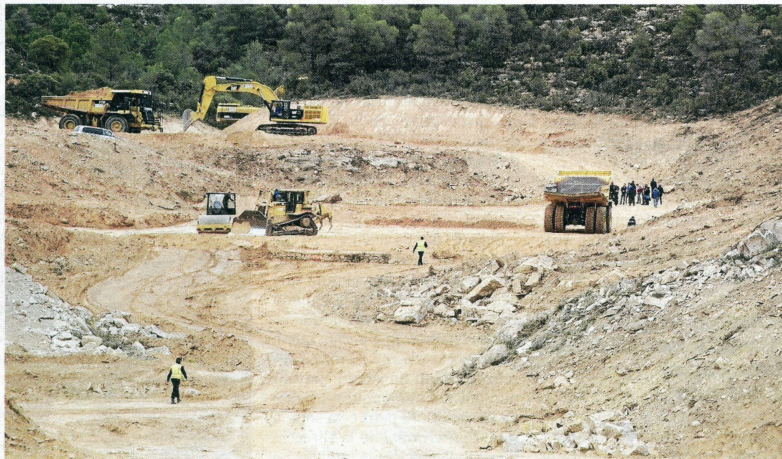
Imatge de l'espai on s'està construint actualment el dipòsit de residus de Riba-roja d'Ebre. FOTO: JOAN REVILLAS
