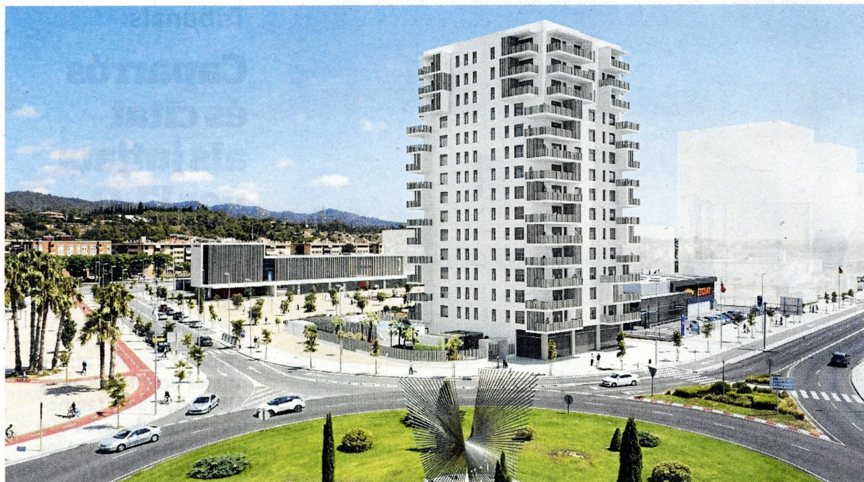
Maqueta de la nova torre de pisos. FOTO: SB INMOBILIÀRIA
