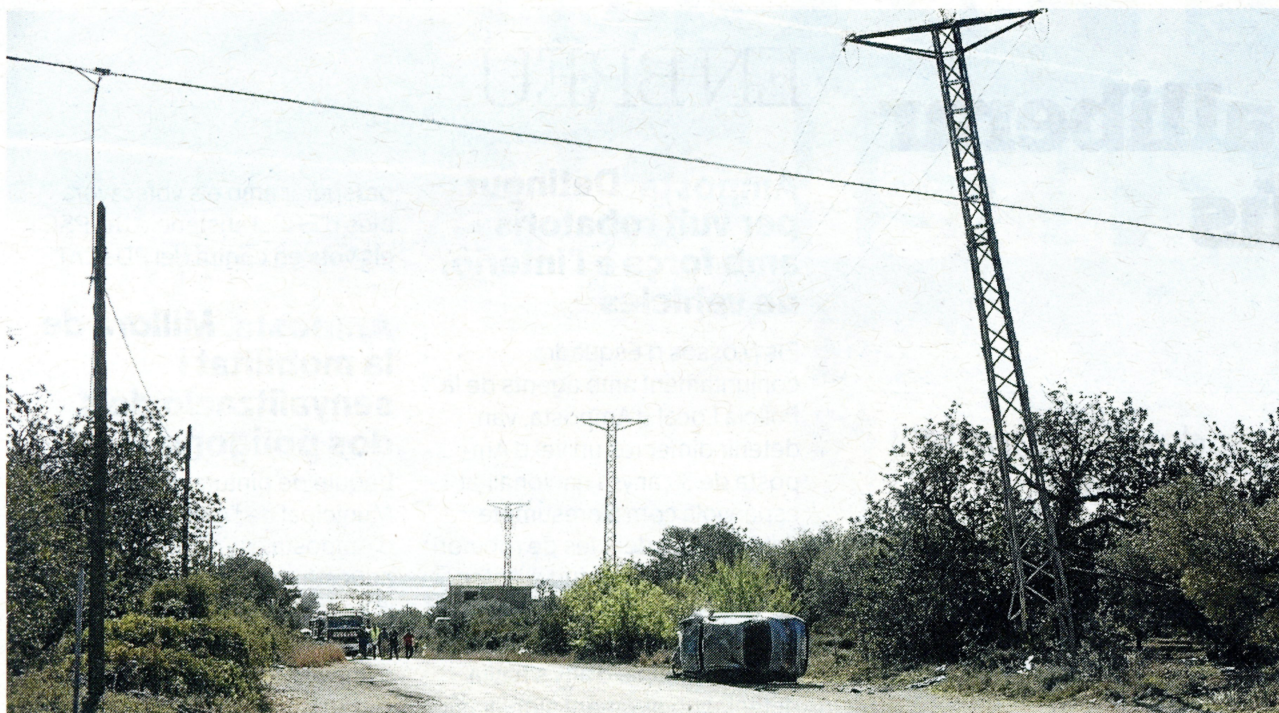
Imatge del vehicle que ahir va col·lidir amb una torre elèctrica, a l'Ampolla. FOTO: JOAN REVILLAS
