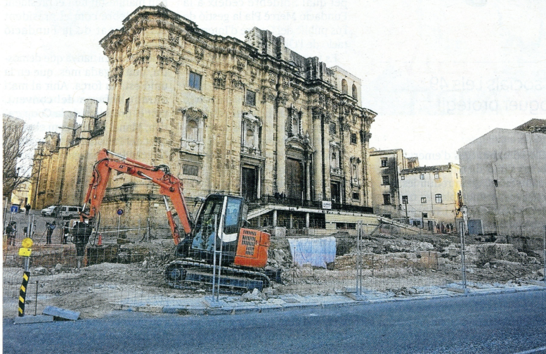
Imatge dels treballs, ahir al matí, que permetran millorar tot l'entorn. FOTO: JOAN REVILLAS
