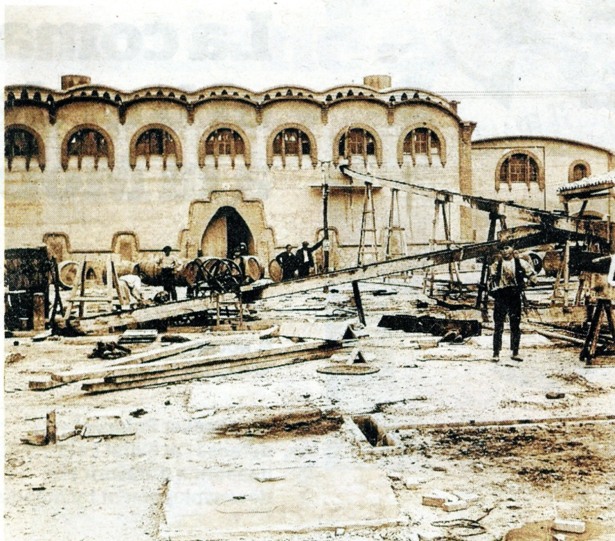
Construcció del Celler Cooperatiu de Gandesa, any 1922.
