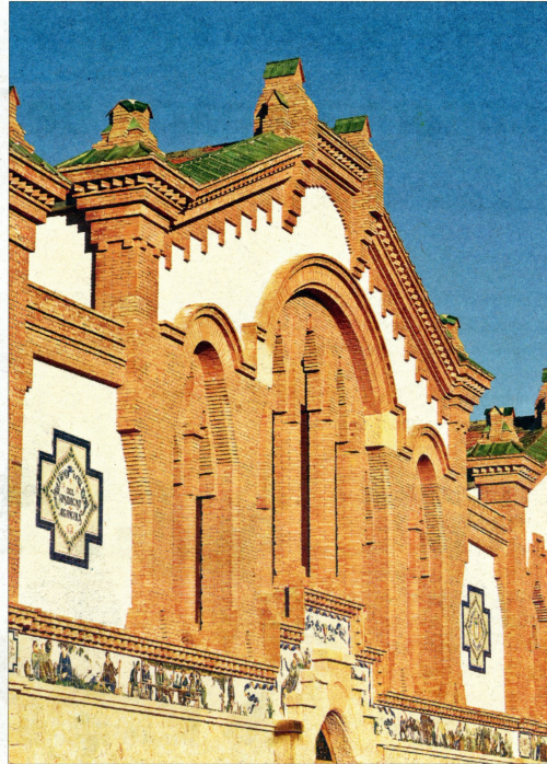
Un detall de l'exterior de l'edifici. /VILLA RETIRO GRUP
