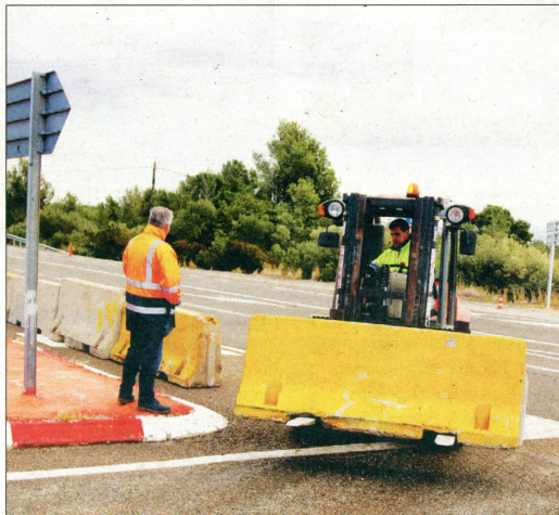
Treballs previs a la construcció d'una rotonda a l'Almadrava. / ACN
