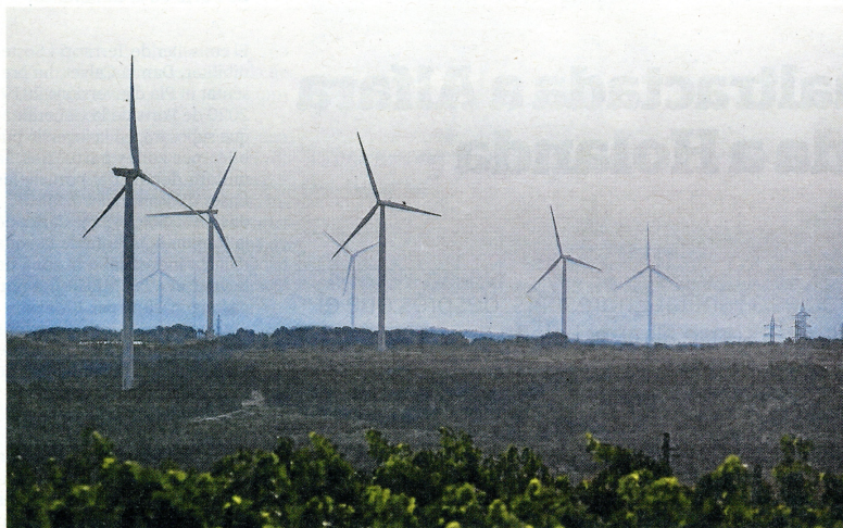
Imatge d'un parc eòlic a la Terra Alta. FOTO: JOAN REVILLAS
