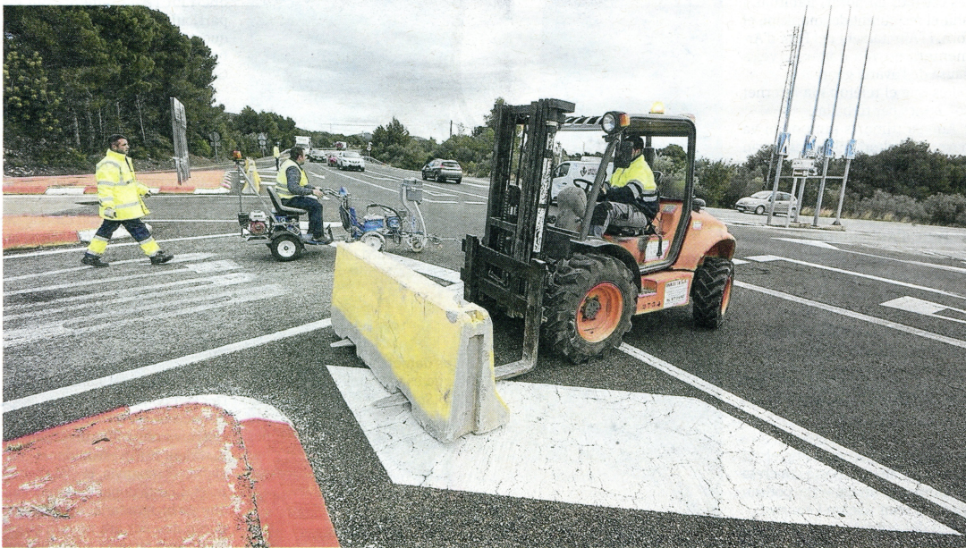
Els operaris van començar ahir, divendres, a treballar en la construcció de la rotonda a l'altura de l'Almadrava. FOTO: JOAN REVILLAS
