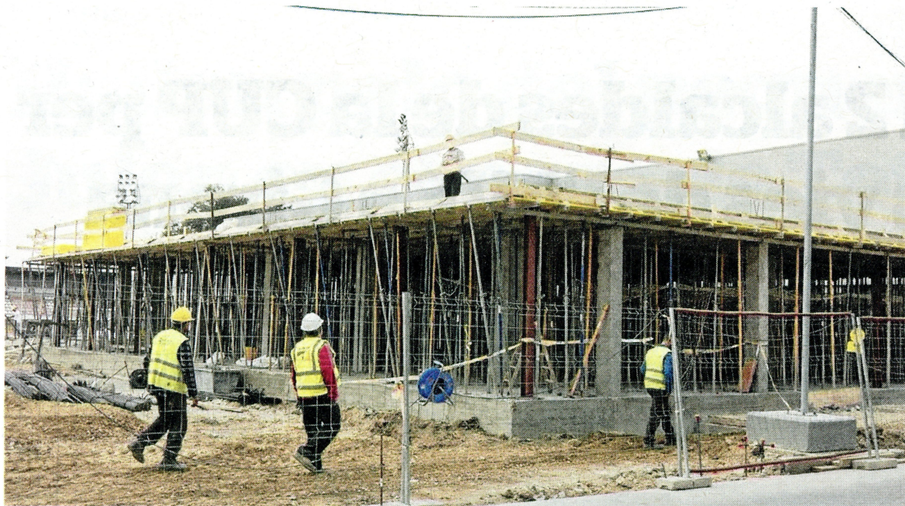
Imatge de la segona fase de les obres al nou complex esportiu, ahir a la tarda. FOTO: JOAN REVILLAS
