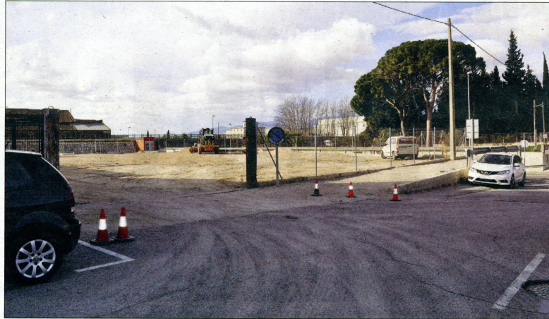
Imatge presa esta setmana dels treballs per a habilitar el nou aparcament en superfície. / NÚRIA CARO
