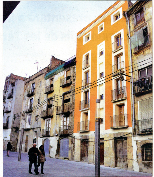
A la fotografia un edifici que esta sent rehabilitat a la plaça Gerard Vergés. NÚRIA CARO
