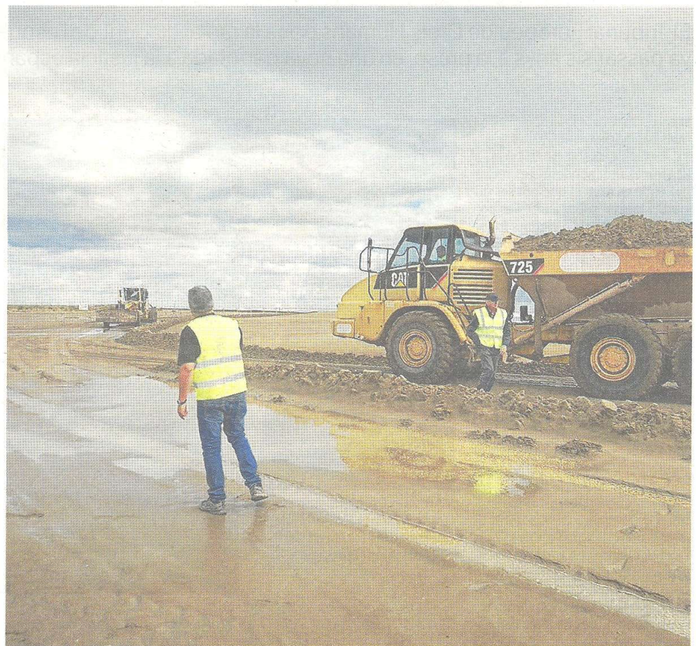
Imatge del moment en què s'estaven efectuant les obres a les llacunes de l'illa de Buda. FOTO: JOAN REVILLAS
