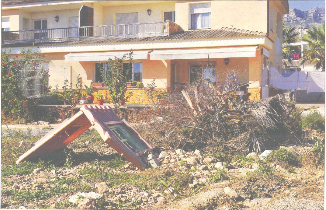
L'aigua va castigar especialment la urbanització de Serramar, a Alcanar Platja, on va arrossegar de tot i va tombar algun mur. / NÚRIA CARO
