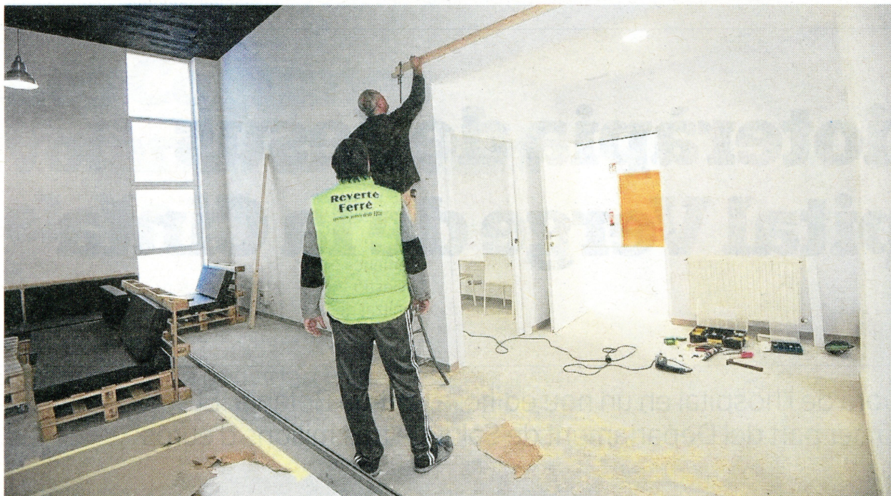
Els operaris treballant en l'última fase de les obres del nou Espai Jove. FOTO: JOAN REVILLAS
