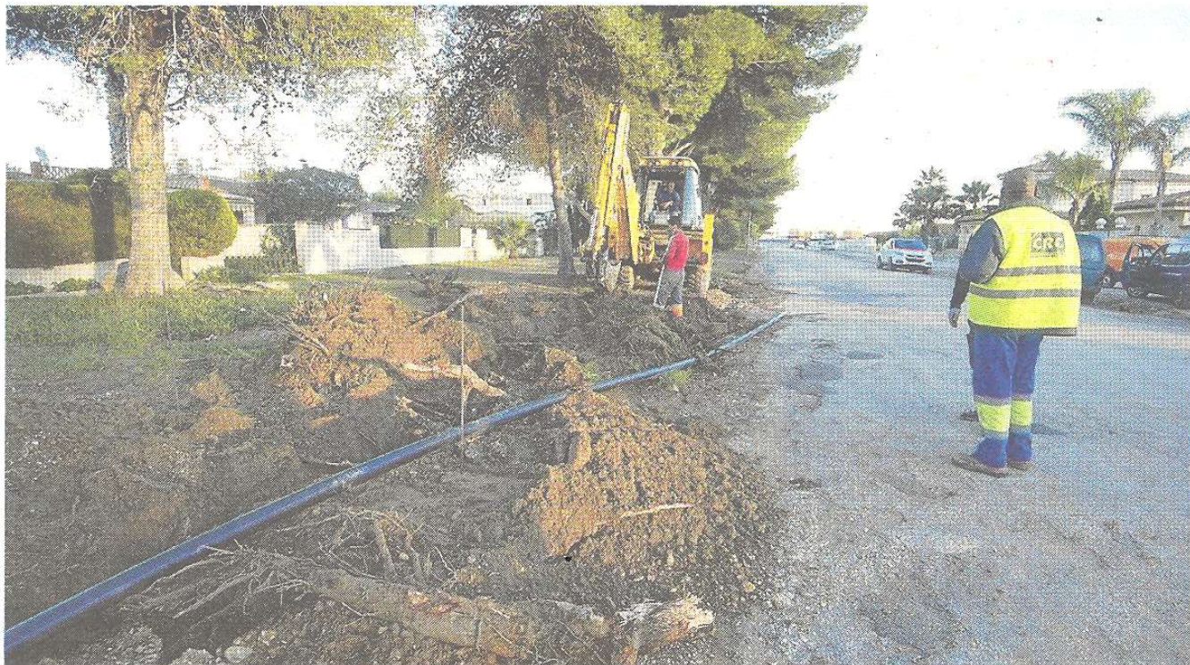
Obres d'urbanització al nucli urbà de Riumar. FOTO: JOAN REVILLAS
