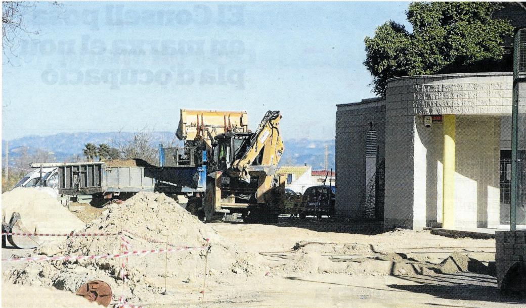
Imatge actual de l'exterior del complex esportiu de Deltebre, en procés d'obres. FOTO: JOAN REVILLAS
