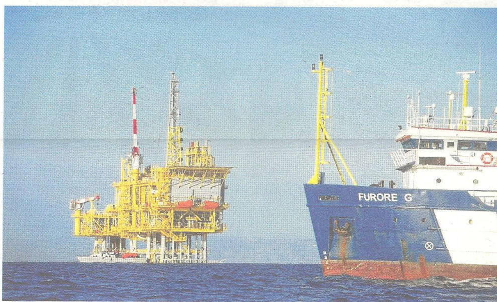
La plataforma marina del projecte Castor, davant la costa de Vinaròs i Alcanar. FOTO: JOAN REVILLAS
